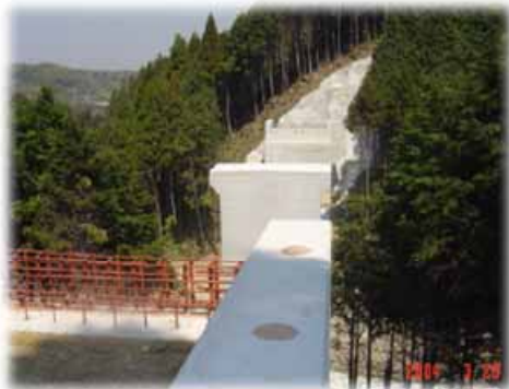
建設中の橋脚
