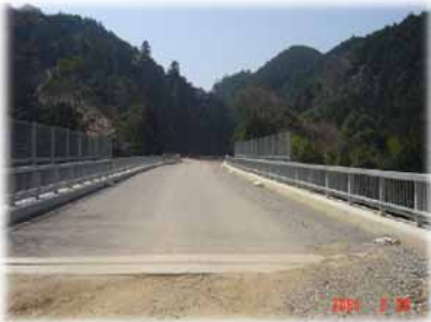
完成した小川西橋
