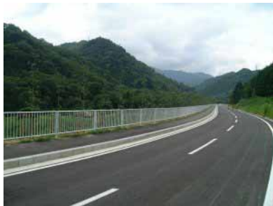
(建設中の道路)
